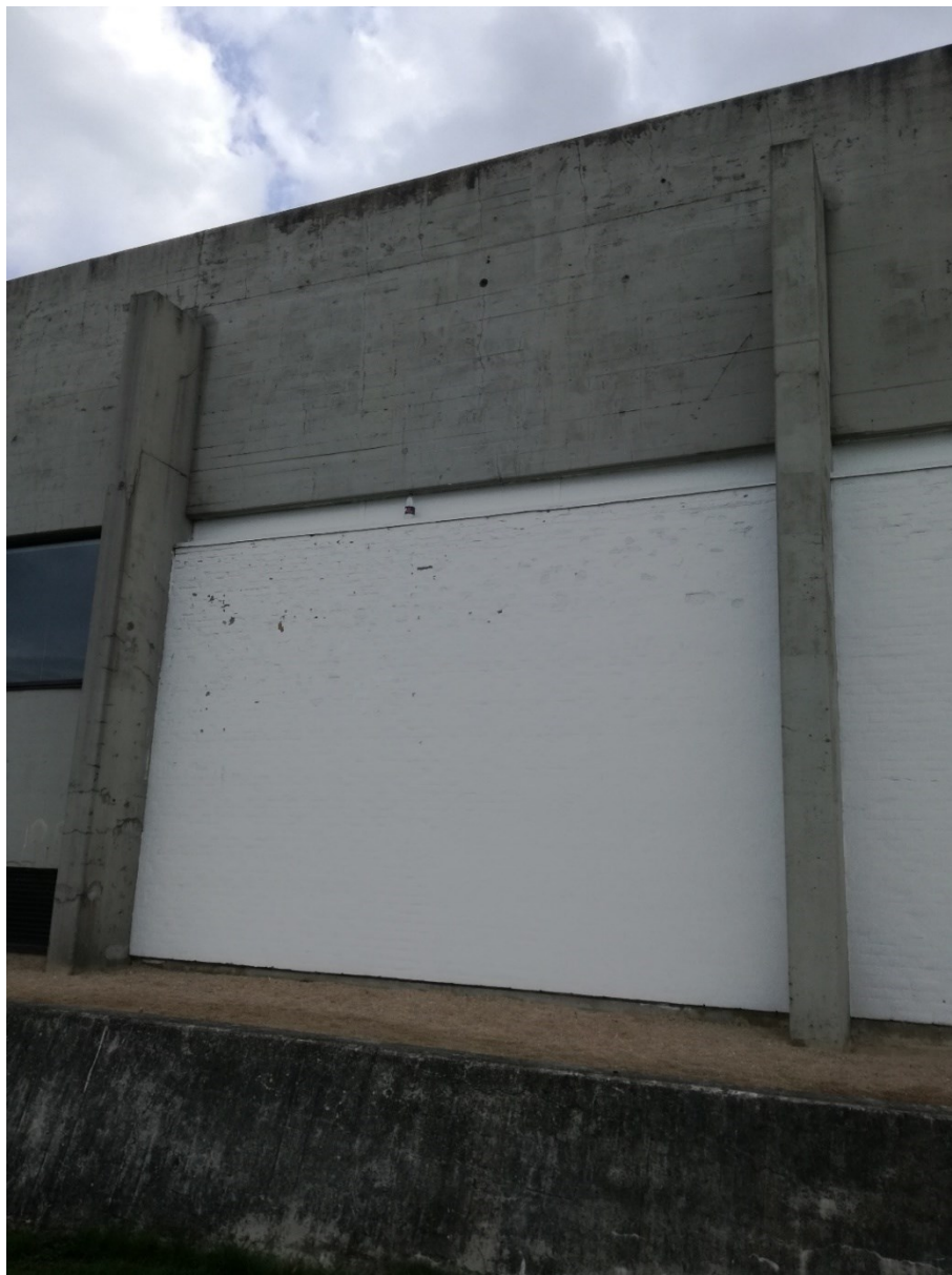
Figur 6.6 Hvidmalet murværk på vestfacade
