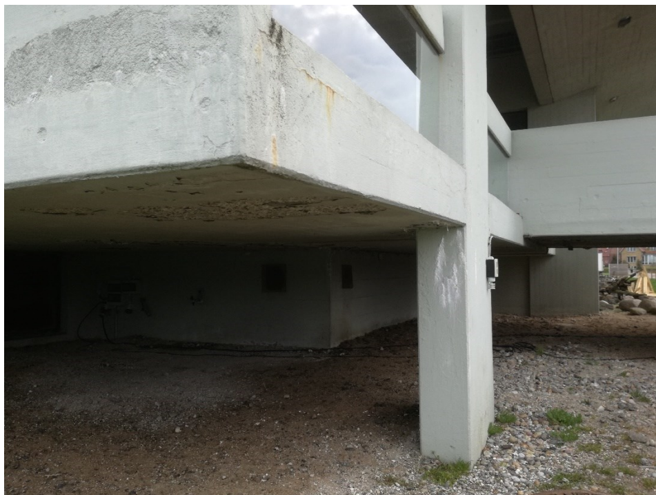
Figur 6.3 Platform ved indgangsparti
