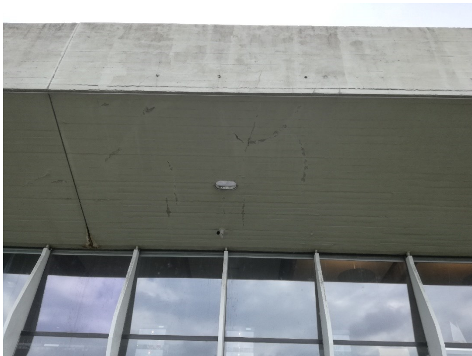
Figur 6.7 Tagudhæng fra undersiden på sydfacade
