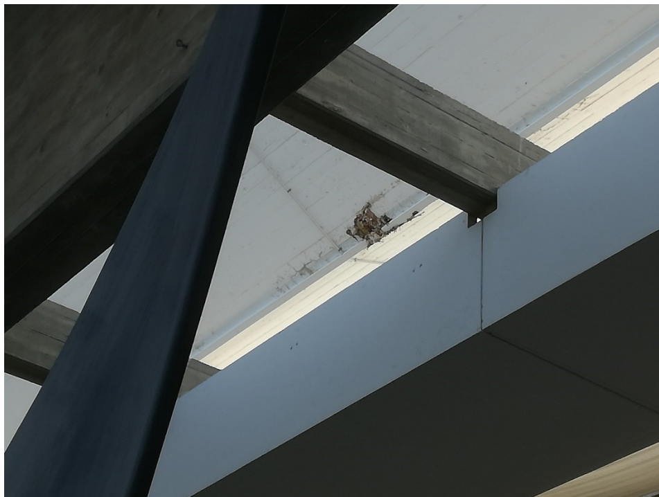
Figur 6.38 Fugtskade indvendigt
