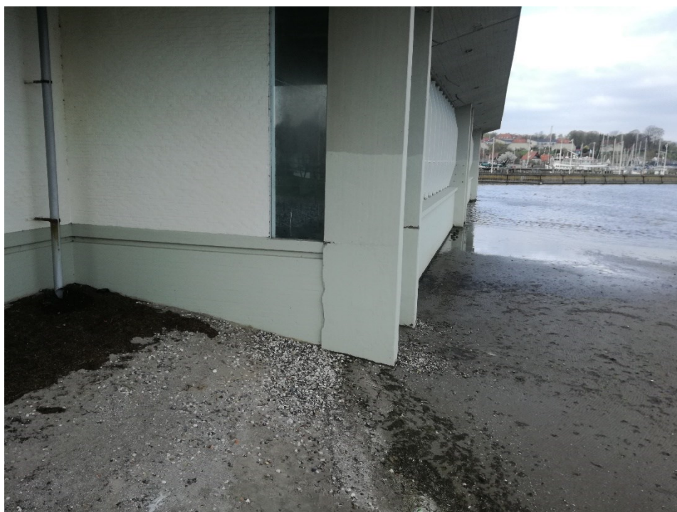
Figur 6.11 Nordfacade set fra øst. Der er påført malebehandling på nederste del af facaden.
