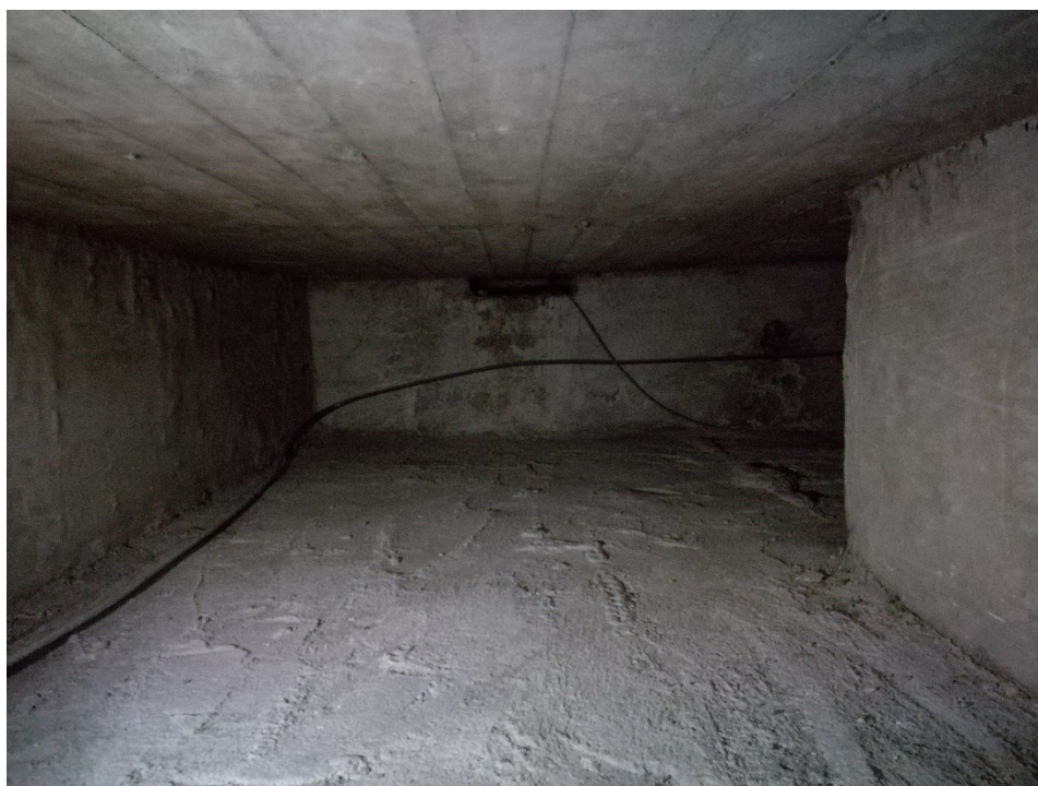
Figur 6.30 Krybekælder under udstillingshal
