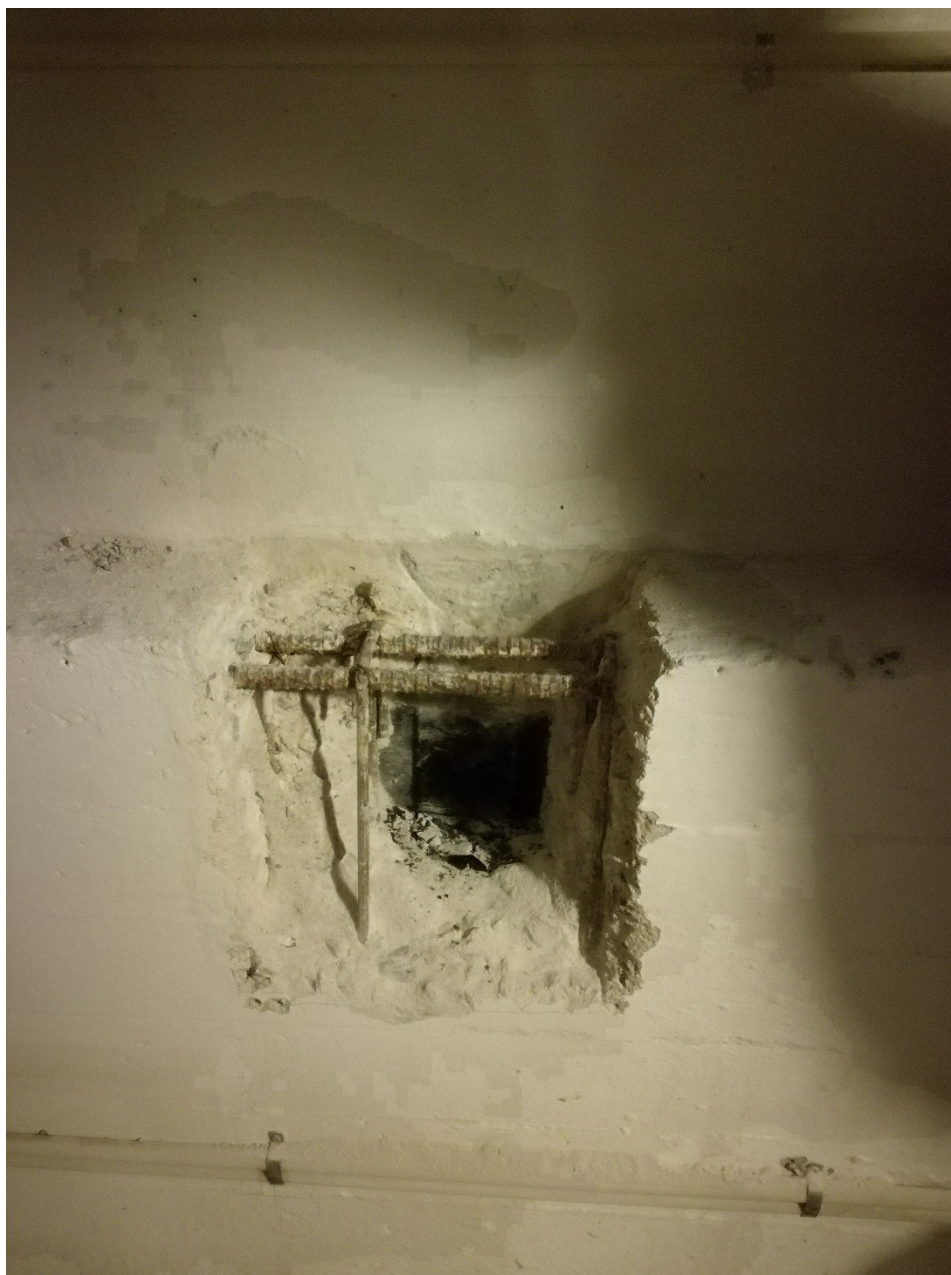
Figur 6.40 Ophugning til membran i kælder
