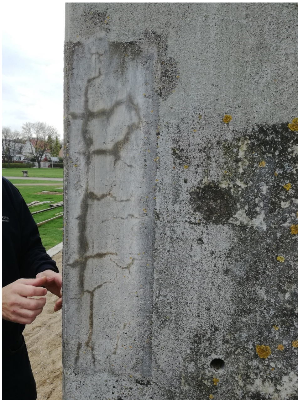
Figur 6.12 Betonreparation på søjle på østfacade
