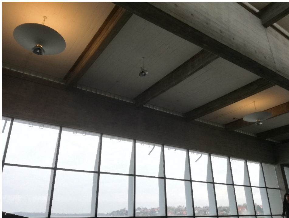
Figur 6.29 Nordfacadens vinduesparti indvendigt
